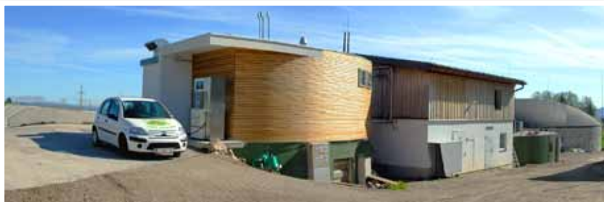
Biogasanlage der Graskraft Reitbach mit Biomethantankstelle
