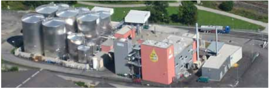
Produktionsanlage von Biodiesel Kärnten in Arnoldstein
