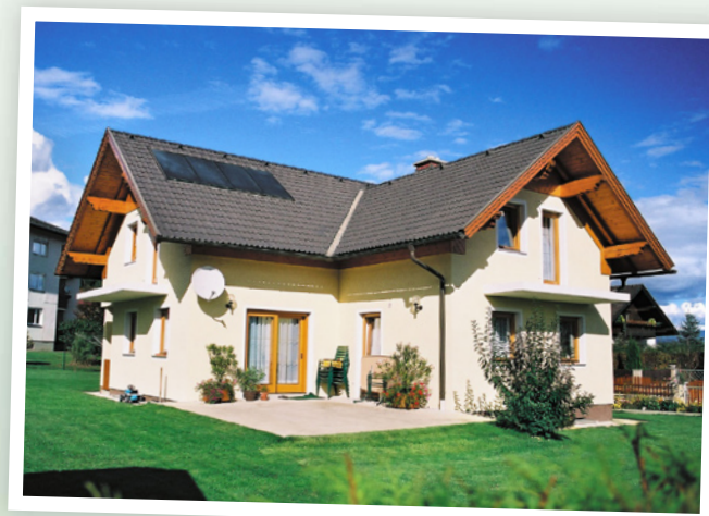
Die Kombination einer Solaranlage mit einem Biomasse-Nahwärmeanschluss ist eine gute Möglichkeit.
