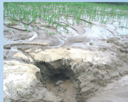
Anzeichen von Vernässung im Boden
