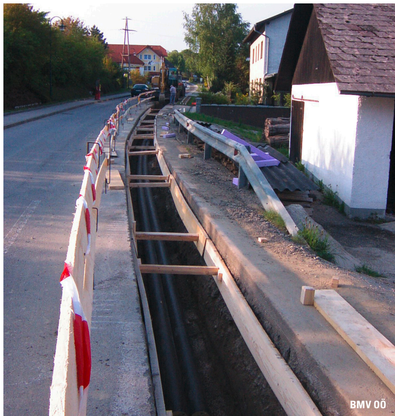
Leitungsbau für eine Biomasse-Nahwärmanlage.
