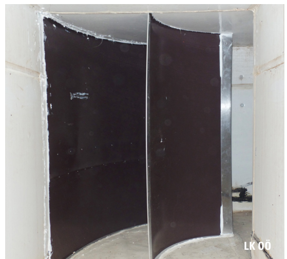
Einbau von Leitblechen in Lüftungskanälen, wodurch der Energieverbrauch reduziert wird.
