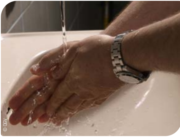
Abb. 43: Der Vorraum muss über geeignete Händewascheinrichtungen verfügen.
